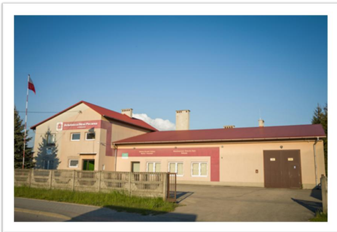
Fot. Nr 1. Wielofunkcyjny budynek komunalny w Dobrynie.
